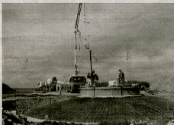
Mille tonnes de béton coulées en moins de dix heures
