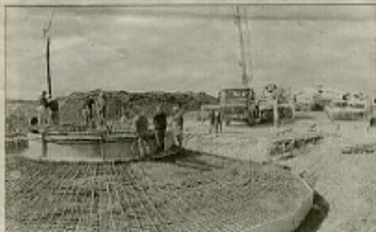
La coulée s'est faite en plusieurs passes de béton
